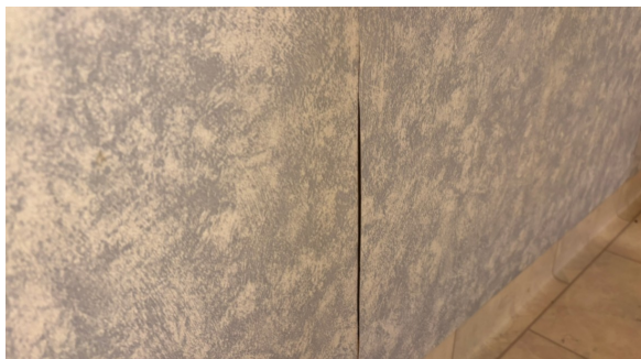
Åpninger i tapetskjøter
