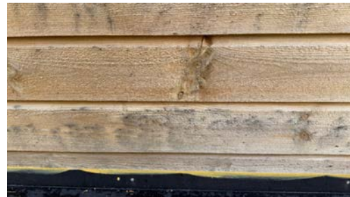
Eksempelbilde av svertesopp på ubehandlet kledning.
