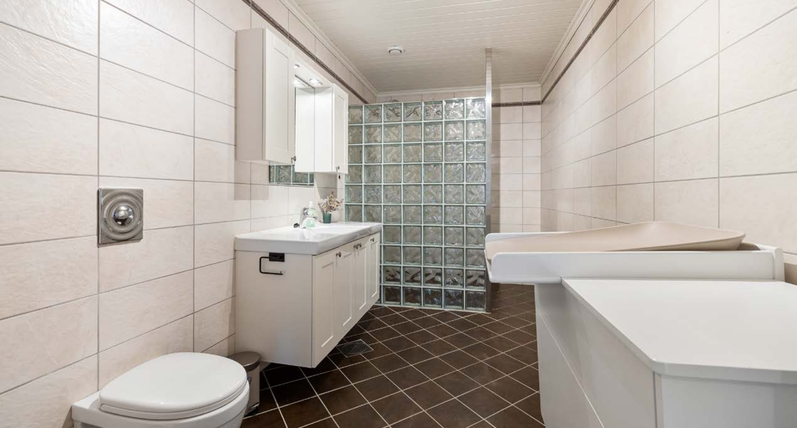
Flislagt bad innredet med vegghengt toalett, servant i baderomsinnredning med speil over og dusjhjørne med glassbyggersteinsvegg.
