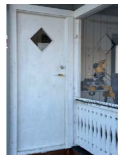
TG 1 Balkonger, terrasser og rom under balkonger
