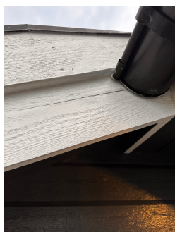
Kledning som kommer litt ut i et par skjøter
