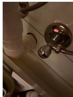
Manglende tetting rundt avløpsr
