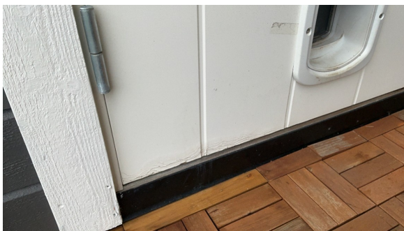
Svelling på dørblad bod 1.etg
