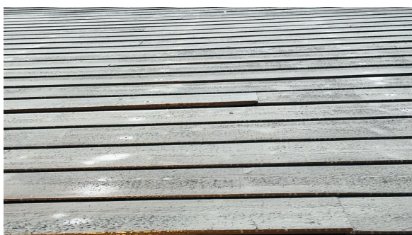
Kledning som kommer litt ut i et par skjøter
