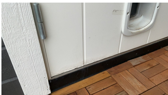
Svelling på dørblad bod 1.etg
