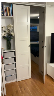
Dørblad til det største soverommet i 1.etg lukker ikke helt inntil karmen i bunn.
