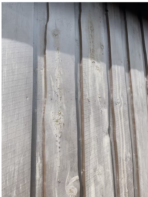
Utslag av kvæ
