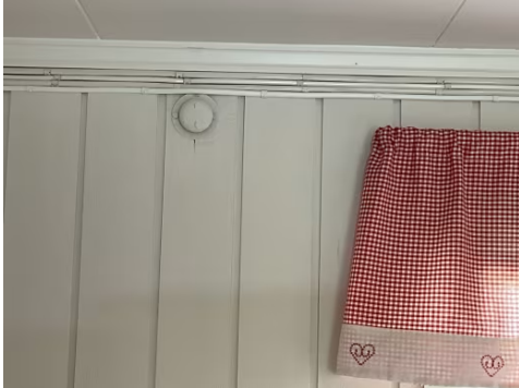
Lufteluker i vegg.
