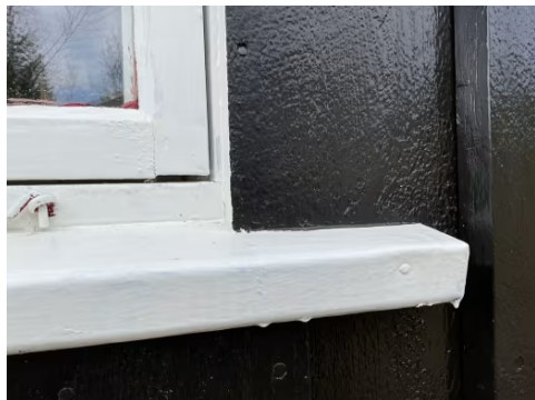
Panel ned til vannbrett.
