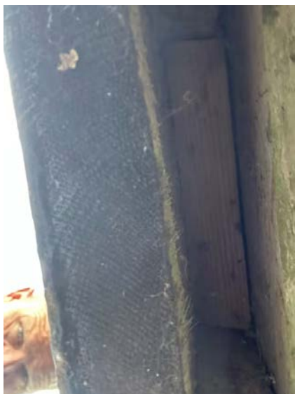
Liten lufting av kledning.
