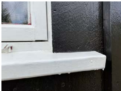
Panel ned til vannbrett.
