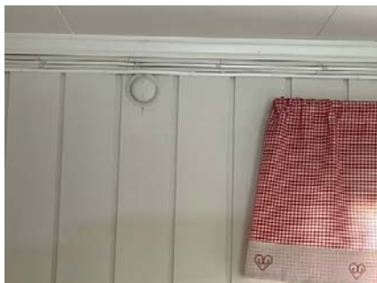
Lufteluker i vegg.
