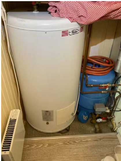
Varmtvannsbereder.
