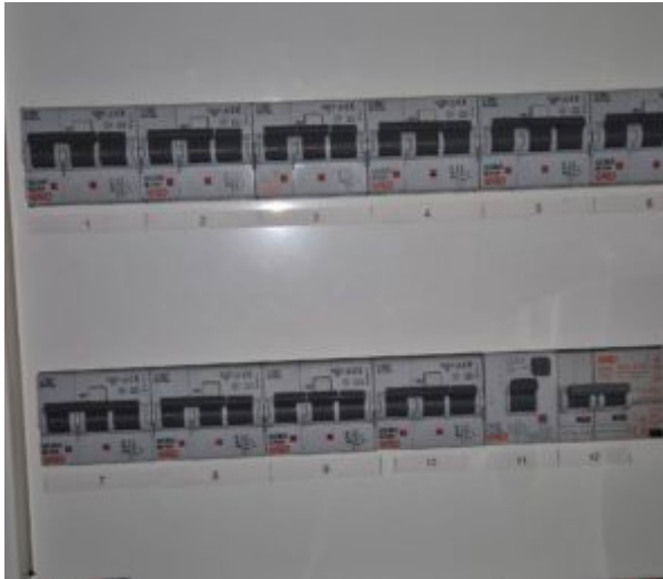
Bilde 1 Testknapp virker ikke på Kurs 4 og 10
