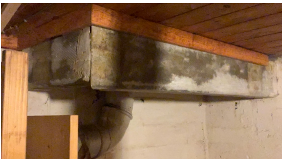
Ventilasjonsrør i kjeller av eternit.
