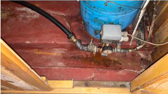
Vanninntak og stoppekran i kjeller.
