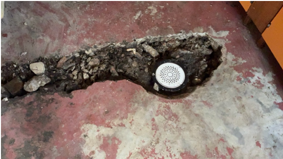
Nyere del av avløpsør.
