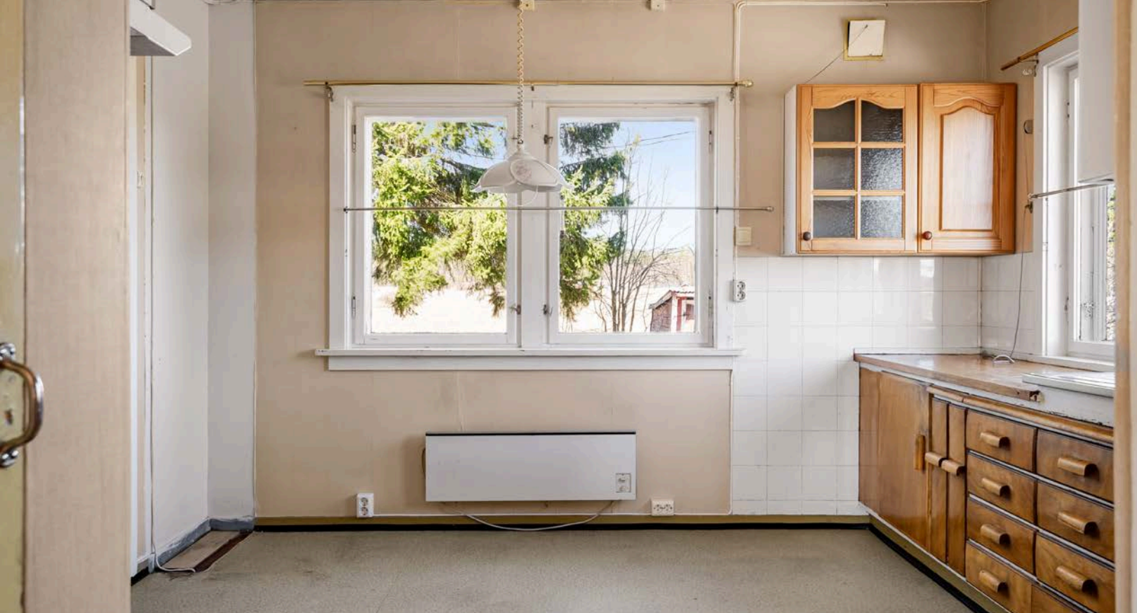
Det er panelovner på enkelte rom i boligen.
