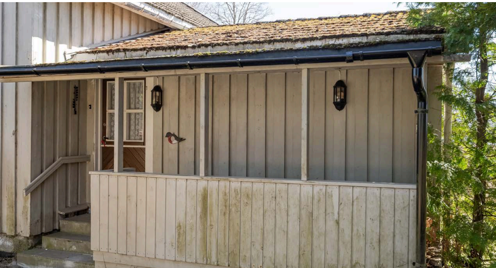
Det ene inngangspartiet har takoverbygg og murtrapp.
