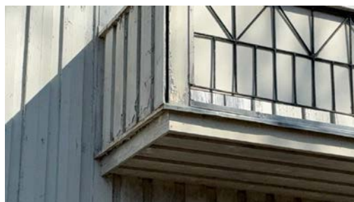
Eksempel på slitasje på overflater.
