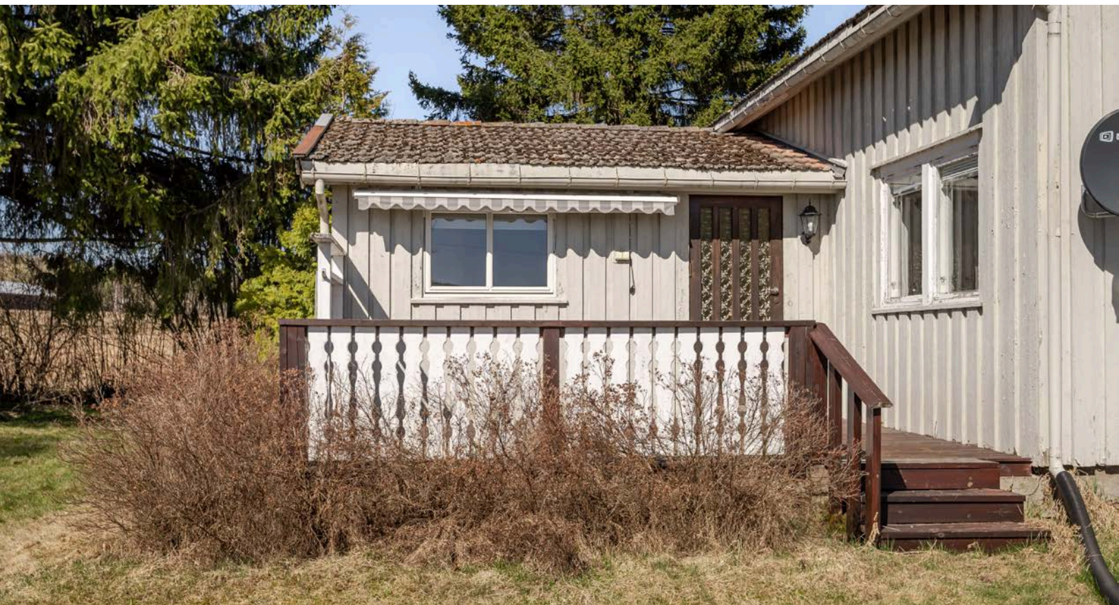
Terrassen ligger i tilknytning til inngangspartiet og vender mot sør.
