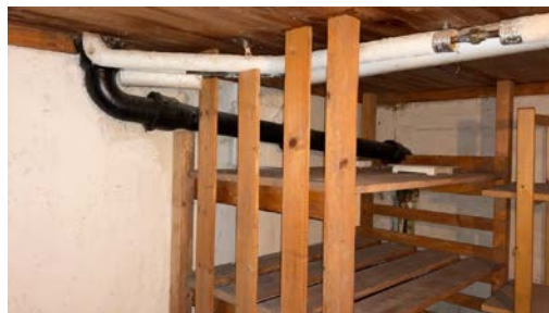
Eldre del av avløpsør.
