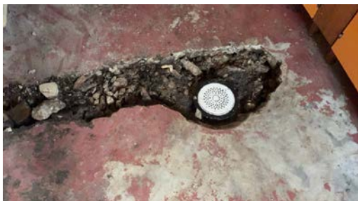
Nyere del av avløpsør.
