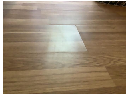
Fuktskadet laminatgulv.
