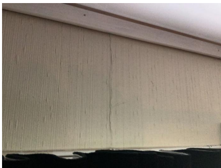
Fuktskadet himlingsplate.
