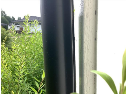
Frostsprengt nedløpsrør.
