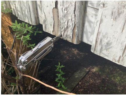
Råteskadet rekkverksbord.
