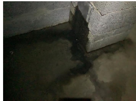
Sotvann under sotluke.
