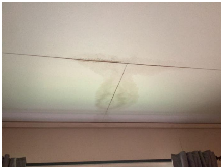
Fuktskadet himlingsplate.
