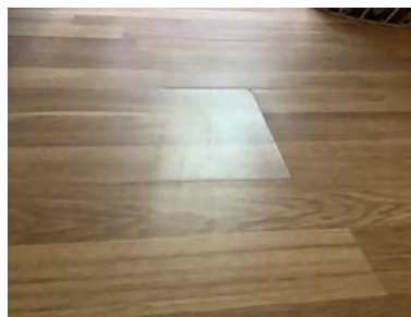
Fuktskadet laminatgulv.
