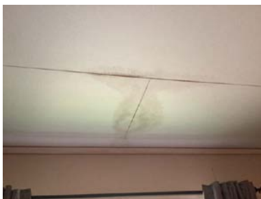
Fuktskadet himlingsplate.
