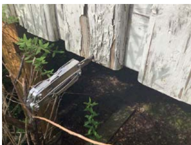
Råteskadet rekkverksbord.
