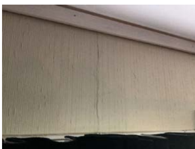
Fuktskadet himlingsplate.
