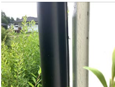
Frostsprengt nedløpsrør.
