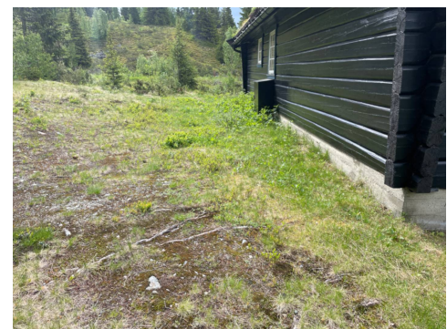
Fall til flatt terreng inn mot grunnmur
