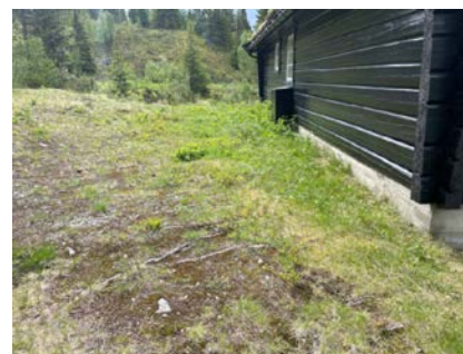
Fall til flatt terreng inn mot grunnmur
