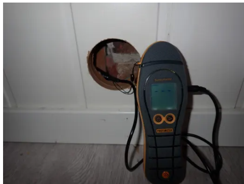
Hulltaking med fuktmålinger tilstøtende rom.
