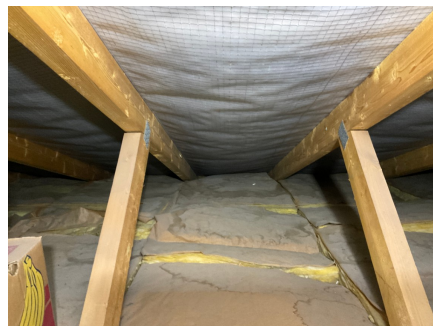
Isolasjon tett mot undertak.
