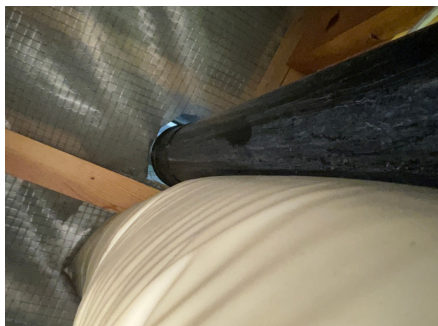
Lufteør fra kaldloft.
