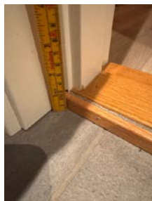
Synlig membran ved dørterksel
