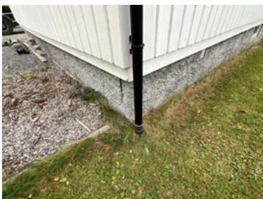
Sprekk grunnmur, ingen utvikling de siste 10 år i følge eier.
