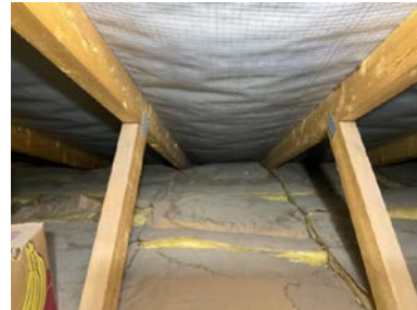
Isolasjon tett mot undertak.
