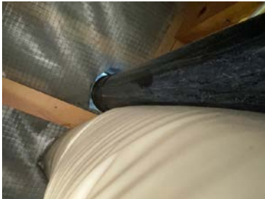
Lufteør fra kaldloft.
