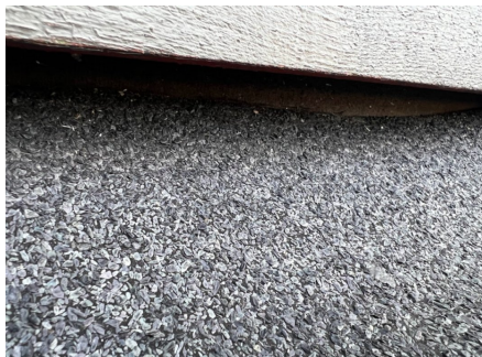
Papptekking avsluttet under kledning
