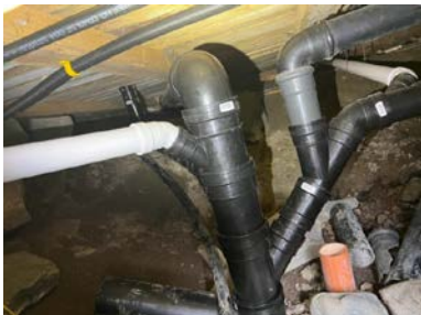
Avløpsrør i krypkjeller
