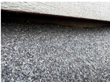
Pappteking avsluttet under kledning
