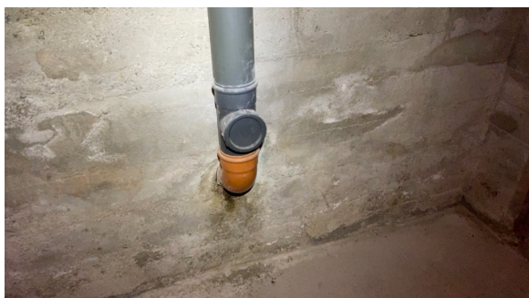
Stakepunkt i kjeller.
