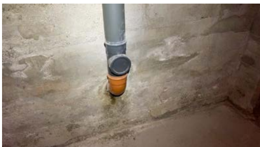
Stakepunkt i kjeller.
