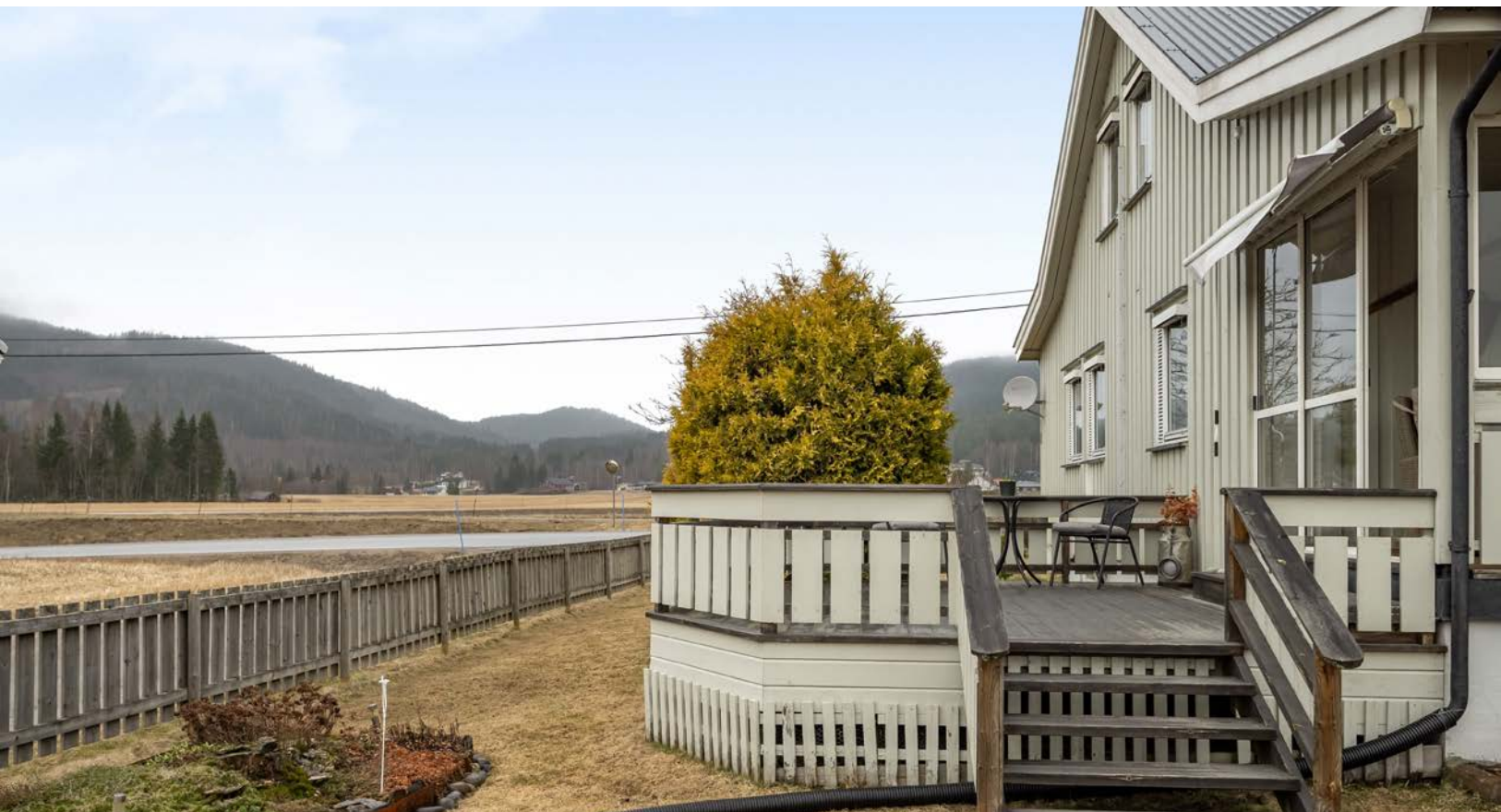
Verandaen har takoverbygg og deler er glasset inn, utført i 2020.
