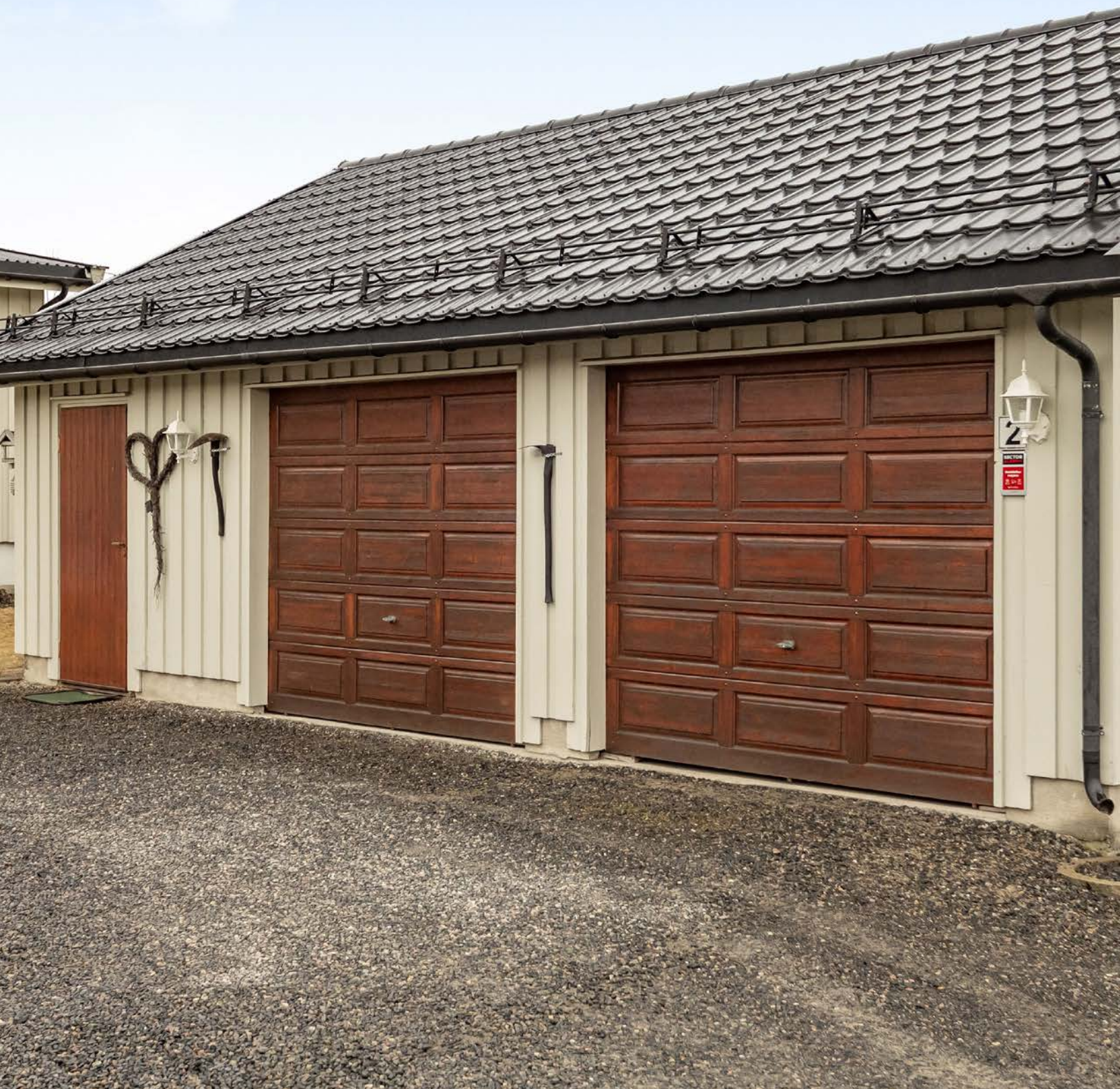
Garasjen ble bygget i 2000 og har to foldeporter. Den er fundamentert med støpt plate på mark og har tak tekket med metallplater.
