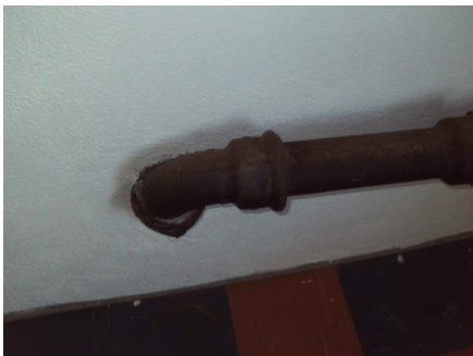
Noen eldre soilrør i underetasjen.
