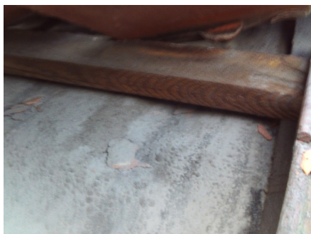
Eldre slitt undertekking av papp.
