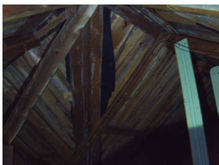
Misfarget undertak (kondensmerker
