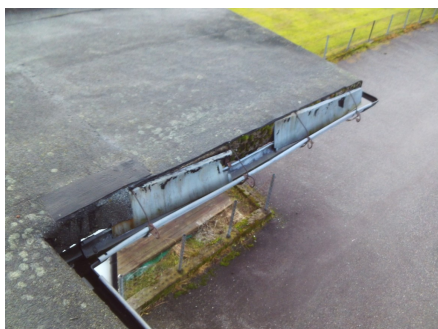
Utett løsning ved overgang til takrenner.
