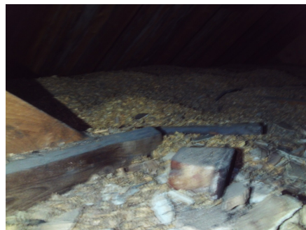
Sagflis som isolasjon
