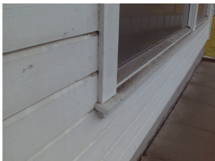
Deler av kledningen med tilhørende belistninger.
