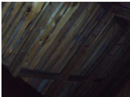
Deler av takkonstruksjone
