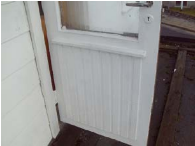
Eldre slitt ytterdør på loftet
