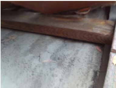
Eldre slitt undertekking av papp.
