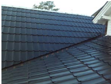
Deler av tekkingen med gradrenne.
