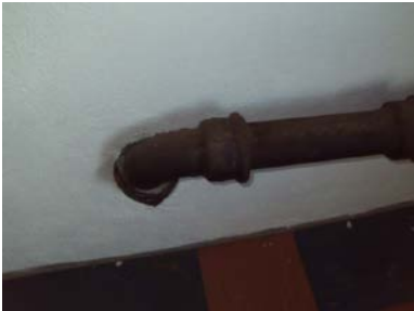
Noen eldre soilrør i underetasjen.
