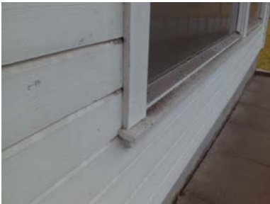
Deler av kledningen med tilhørende belistninger.
