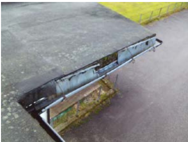
Utett løsning ved overgang til takrenner.
