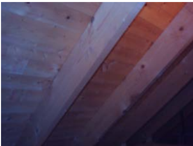
Deler av kaldtloftet over siste tilbygget del.
