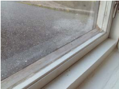
Eldre topphengslet vindu.
