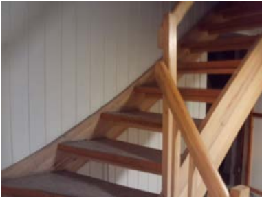
Trapp mellom under og hovedetasjen.
