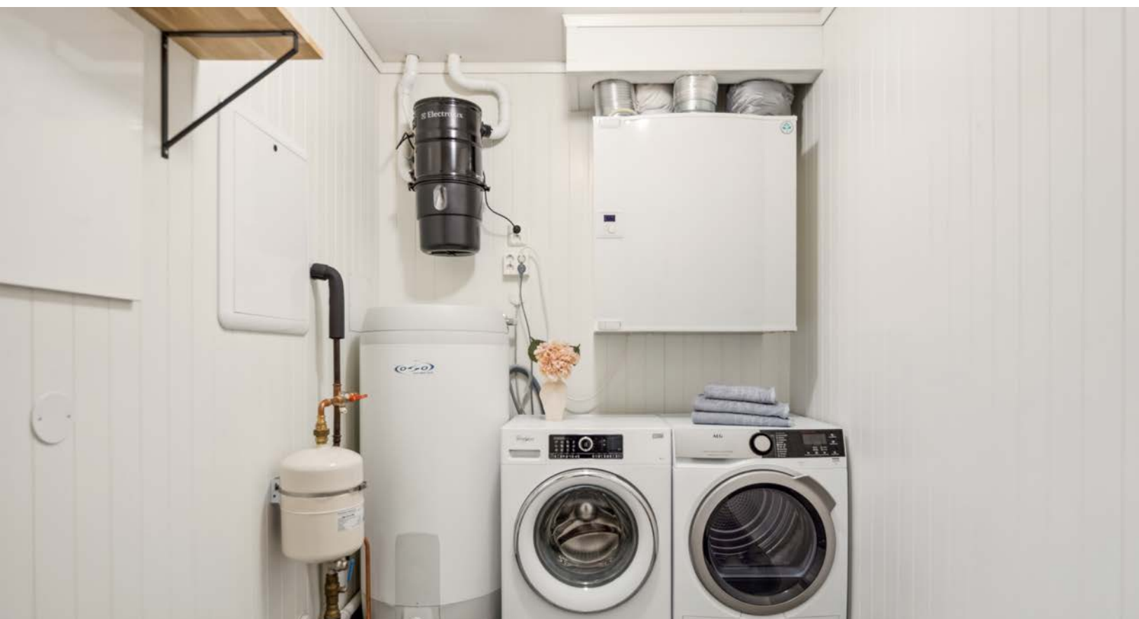
Vaskerom / teknisk rom
