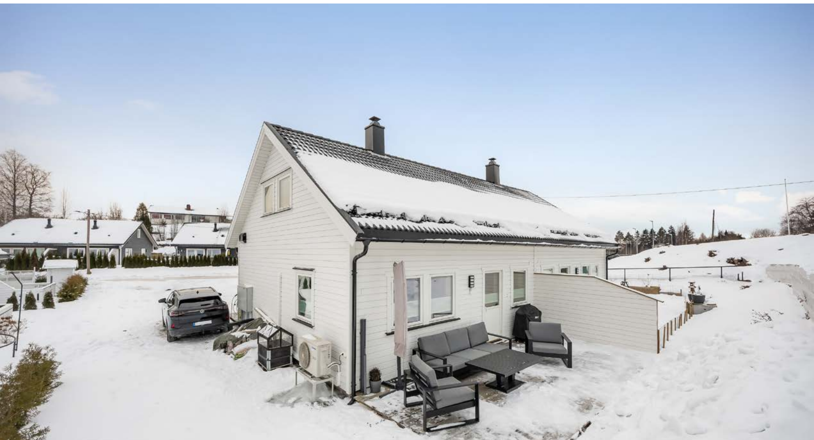
En tiltalende halvpart av en vertikaldelt tomannsbolig over to plan - med gangavstand til alle sentrumsfasiliteter.
