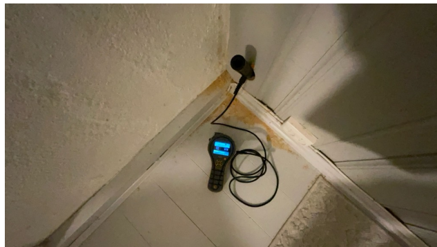
Utført hulltaking på rom under terreng.
