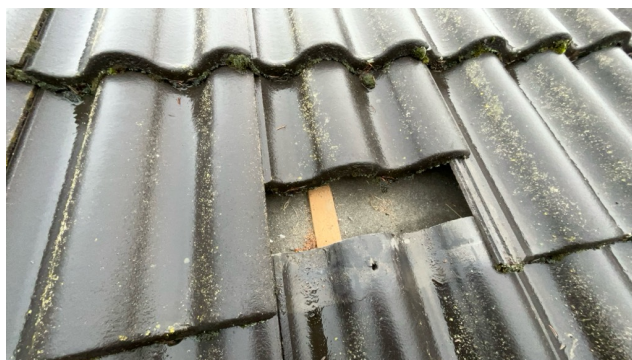
Kontroll av undertak.
