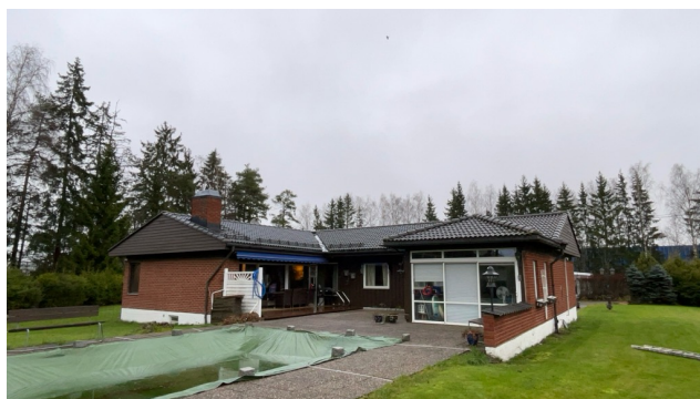
Besiktigelse av taktekke.
