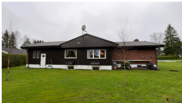
Besiktigelse av taktekke.
