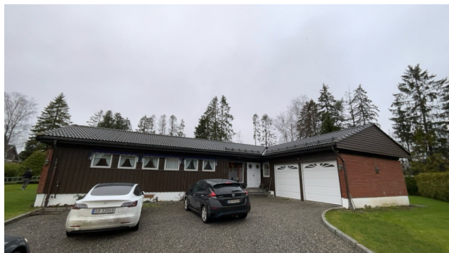
Besiktigelse av taktekke.
