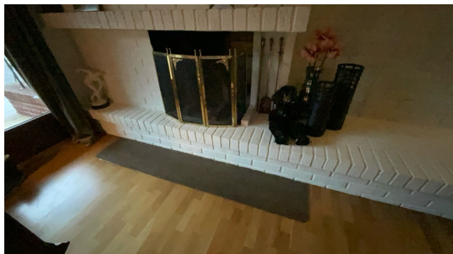
Besiktigelse av ildsted.
