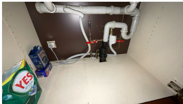
Besiktigelse av rørøpplagg.
