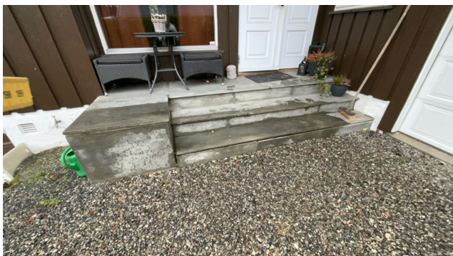
Besiktigelse av trapp.
