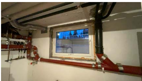
Belistning og tetting må fredigstilles.
