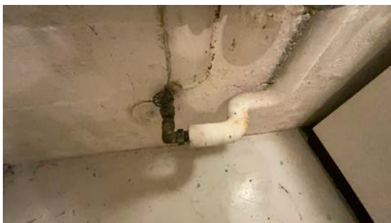
Besiktigelse av røropplegg.
