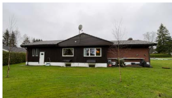
Besiktigelse av taktekke.
