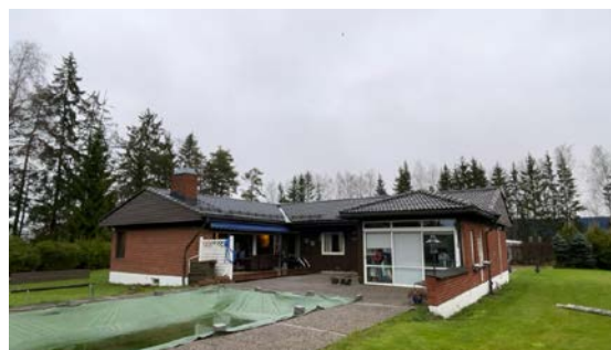
Besiktigelse av taktekke.
