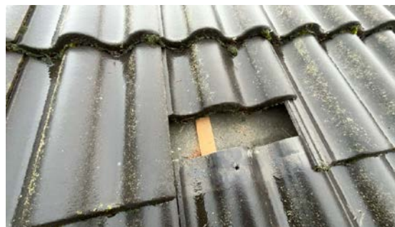
Kontroll av undertak.
