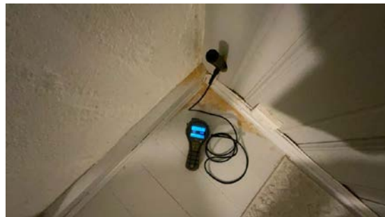
Utført hulltaking på rom under terreng.
