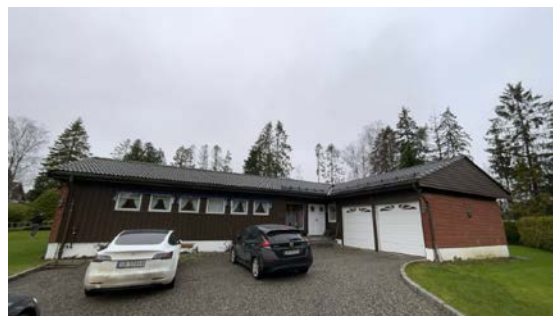
Besiktigelse av taktekke.
