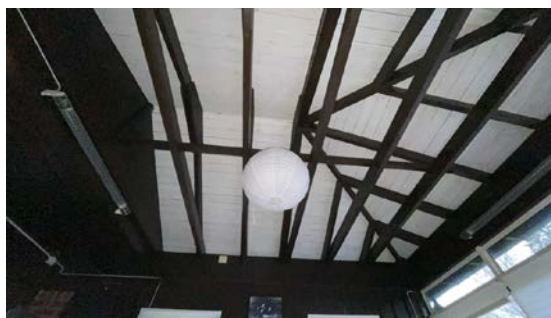
Ingen synlige lekkasjer på undersiden av takkonstruksjonen på befaringsdagen.
