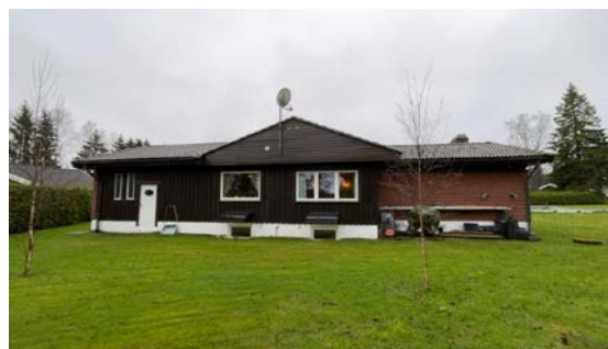
Besiktigelse av taktekke.
