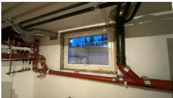
Belistning og tetting må fredigstilles.
