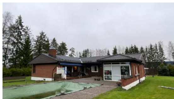
Besiktigelse av taktekke.
