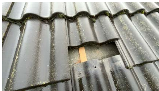
Kontroll av undertak.
