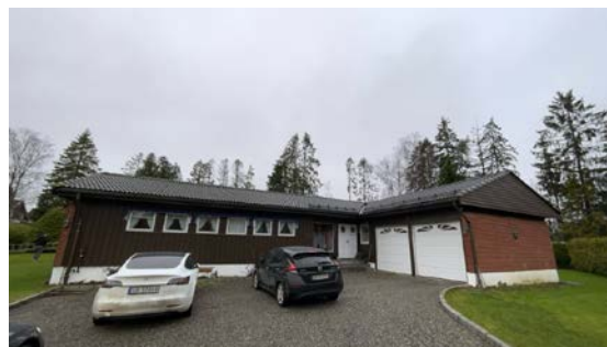
Besiktigelse av taktekke.
