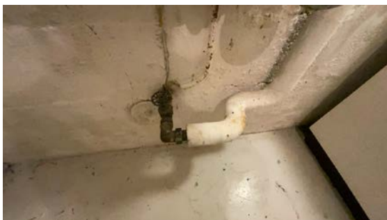
Besiktigelse av røropplegg.
