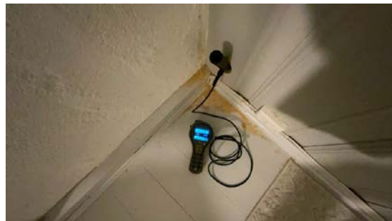
Utført hulltaking på rom under terreng.
