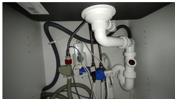
Kontroll av røropplegg.
