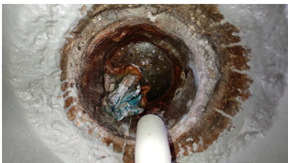
Kontroll av sluk.
