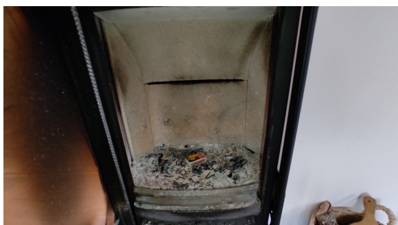
Kontroll av ildsted.
