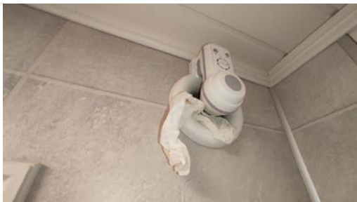
Test av avtrekket.
