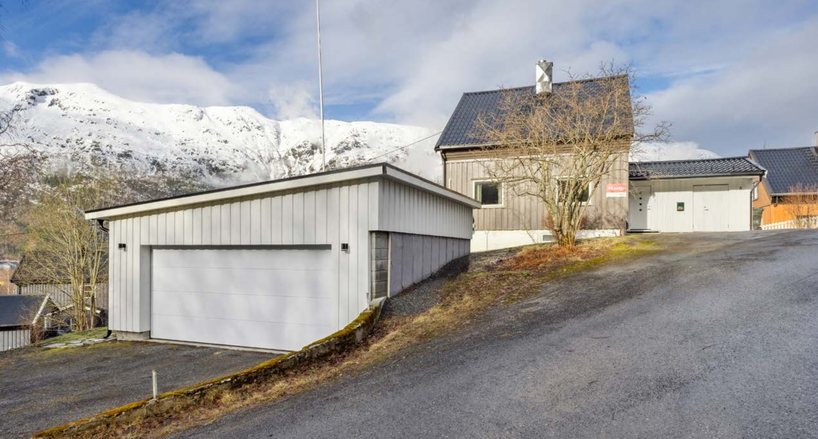
Fasadebilde av bolig og garasjen. Garajsen har to biloppstillingsplasser og el.bil lader
