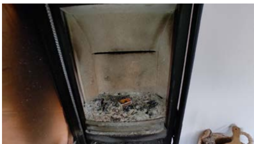
Kontroll av ildsted.
