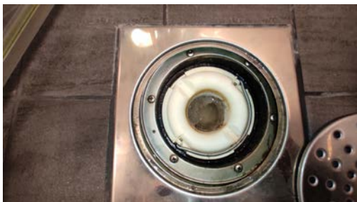
Kontroll av sluk.
