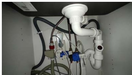
Kontroll av røropplegg.
