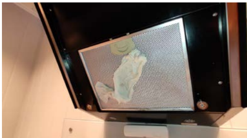
Test av avtrekket.
