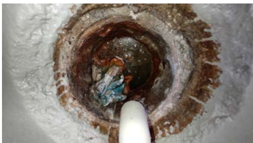
Kontroll av sluk.
