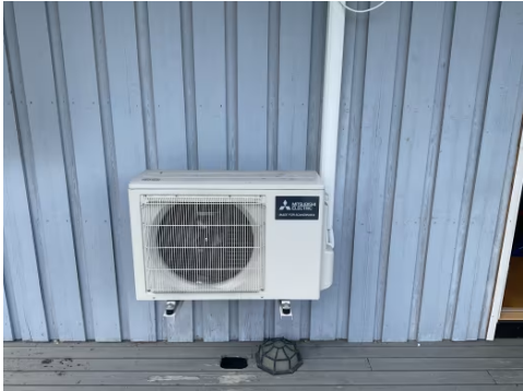
Varmepumpe.
