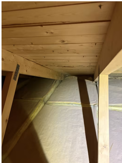
Redusert lufting i raftet.
