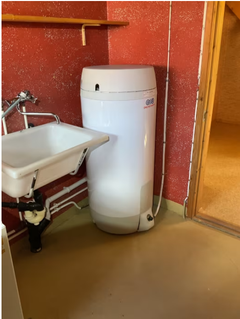
Varmtvannsbereder.
