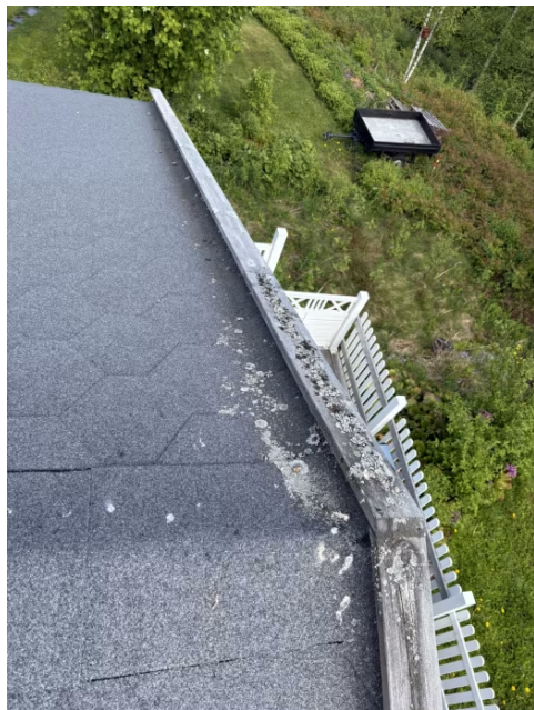
Mose på taktekking.
