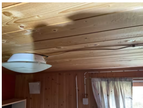
Lampe på vaskerom.
