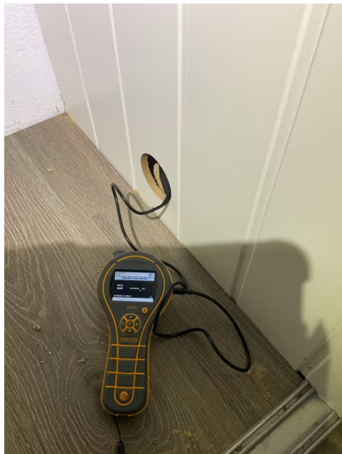
Hulltaking i tilstøtende rom.
