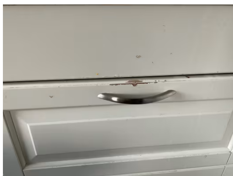
Unormal slitasje på overflater.
