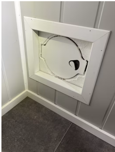
Sotluke i kjeller.
