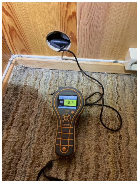
Hulltaking i vegg mot terreng.
