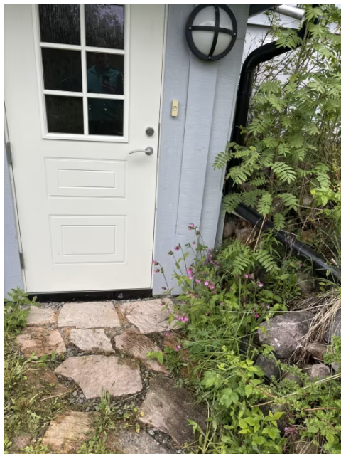
Ytterdør i kjeller.
