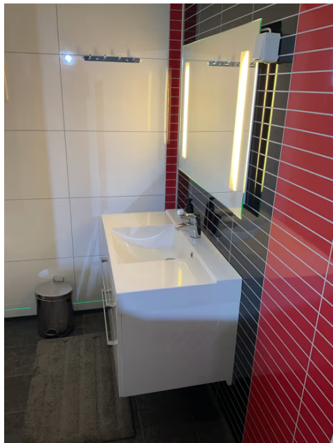
Bad i kjeller.
