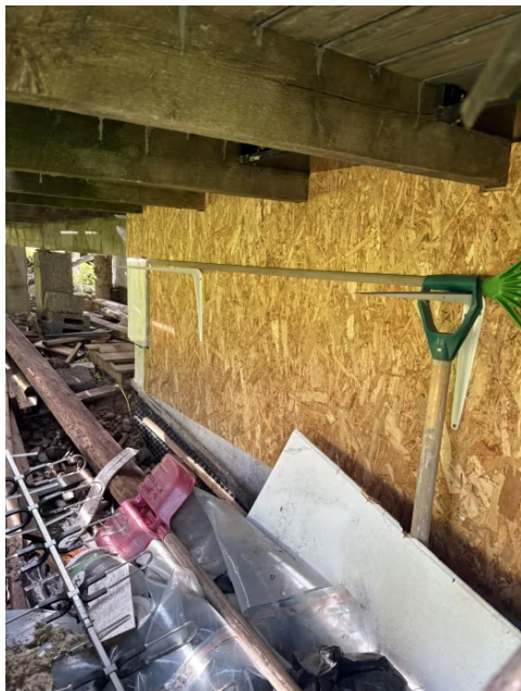
OSB plater utvendig tilbygg.
