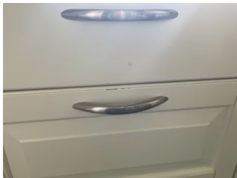
Unormal slitasje på overflater.
