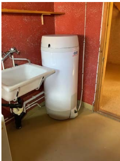
Varmtvannsbereder.
