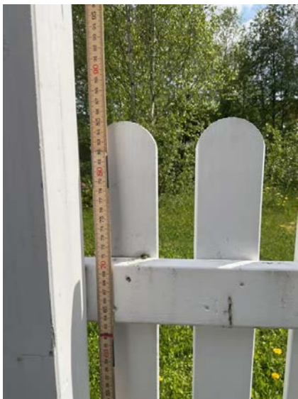
Høyde rekkverk.
