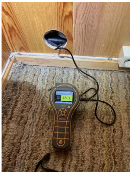
Hulltaking i vegg mot terreng.
