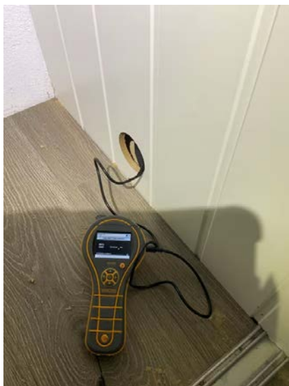
Hulltaking i tilstøtende rom.
