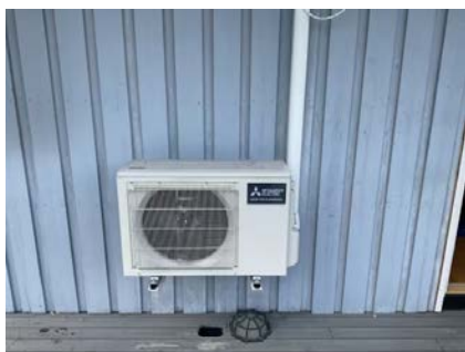
Varmepumpe.
