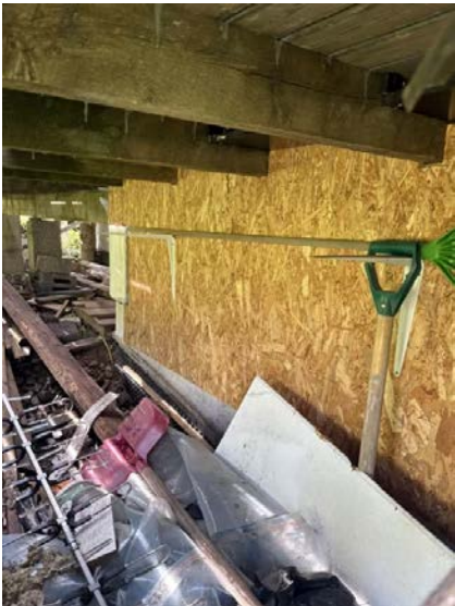
OSB plater utvendig tilbygg.
