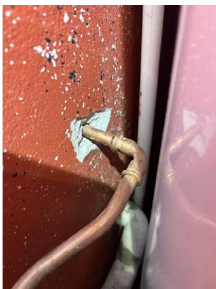
Gjennomføring i vegg.
