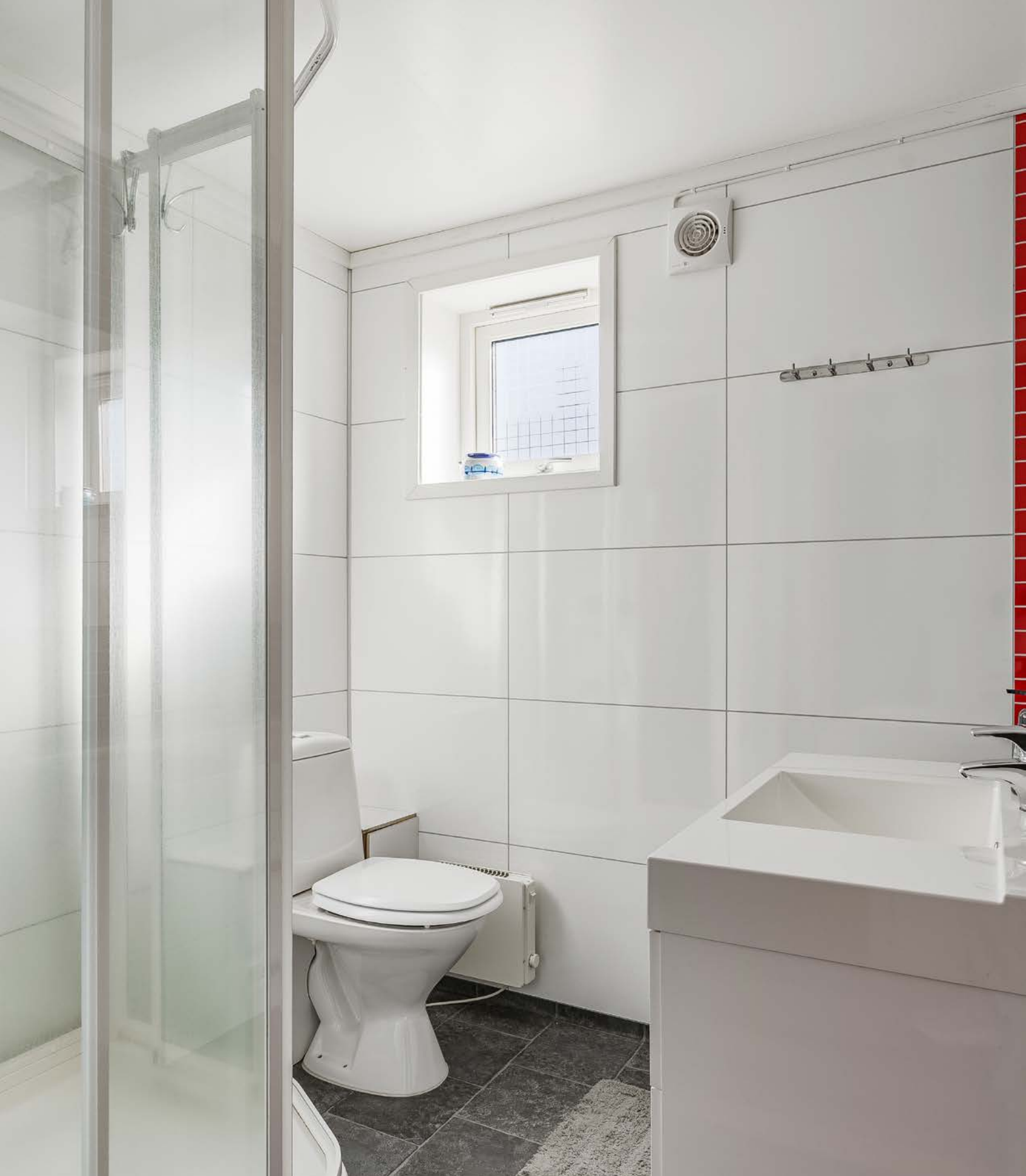
Baderom i underetasjen med belegg på gulv, lyse våtromsplater på veggene og mekanisk avtrekk.
