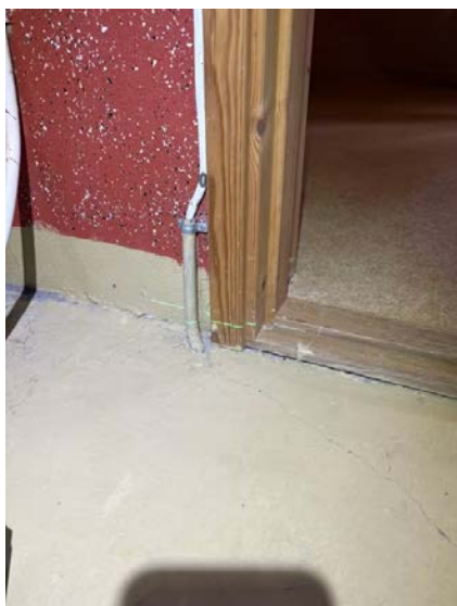
Gjennomføring i gulv.
