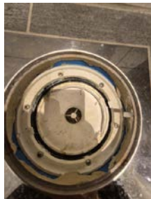
Sluk på gulv har ikke synlig membran under hele klemring - kun delvis.
