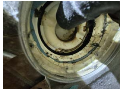
Sluk under kabinett har synlig membran under hele klemring.
