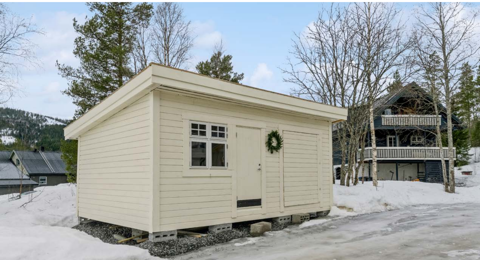
Uthus/vedbod av enkel konstruksjon satt på lettklinkerblokker på terreng. Er ca 24 m 2 .
