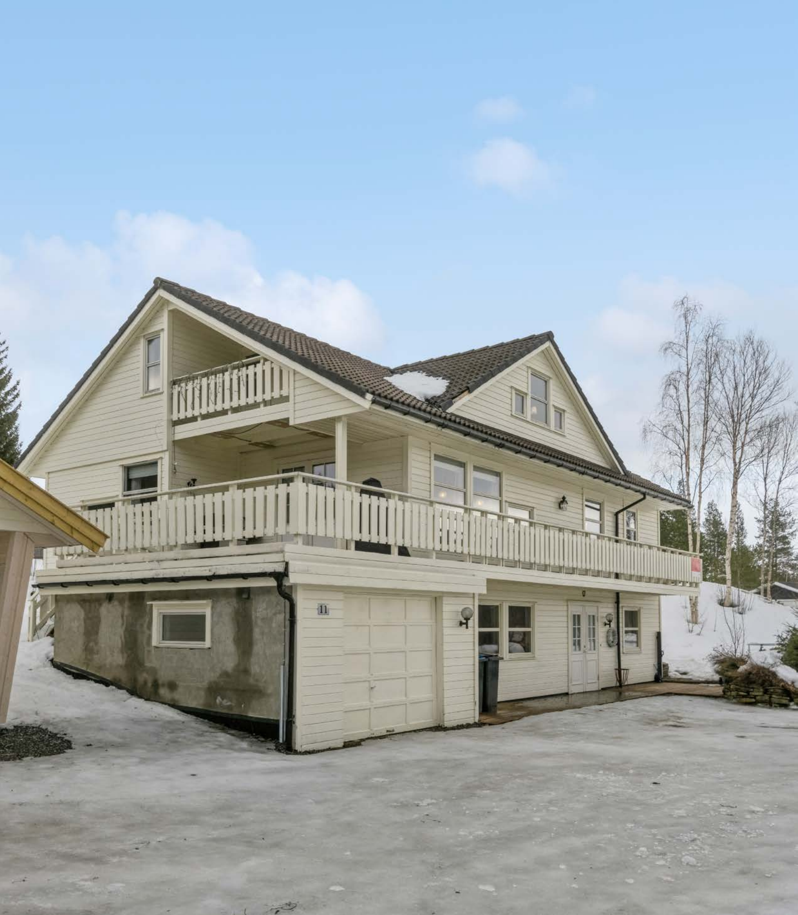
Enebolig på en og en halv etasje over underetasje.
