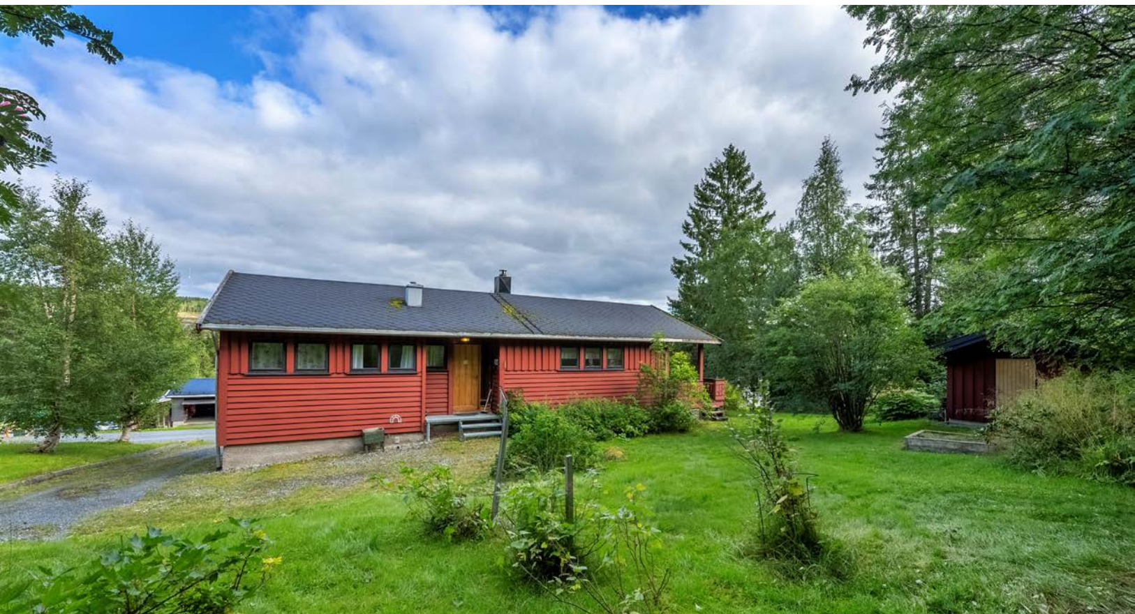
Boligen har hovedinngang i 1. etasje og egen inngang i underetasje
