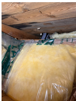
Plast på kald side på knevegger.
