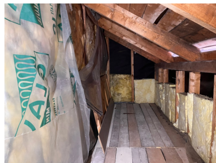
Plast på kald side på knevegger.
