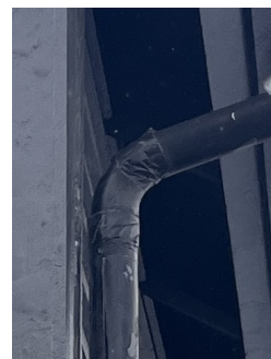
Det er benyttet tape på taknedløp på nordøst side.
