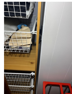
Feieluke bak skap, skal være murt igjen bak luken.
