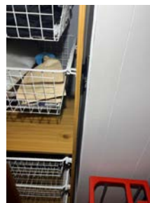
Feieluke bak skap, skal være murt igjen bak luken.
