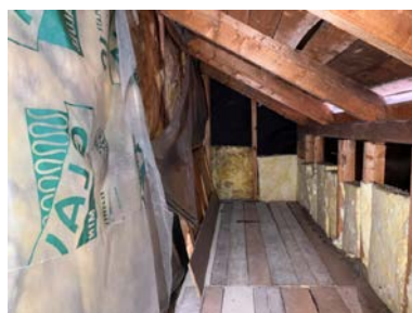
Plast på kald side på knevegger.
