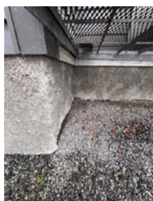
Synlig fuktsikring på nordsiden.
