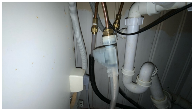
Besiktigelse av røropplegg.
