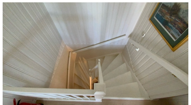
Besiktigelse av trapp.
