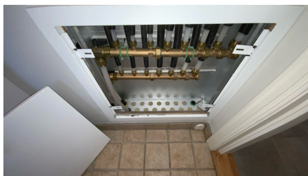
Besiktigelse av røropplegg.
