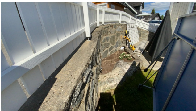
Besiktigelse av støttemur.
