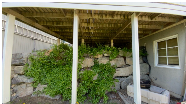
Kontroll av fundament.
