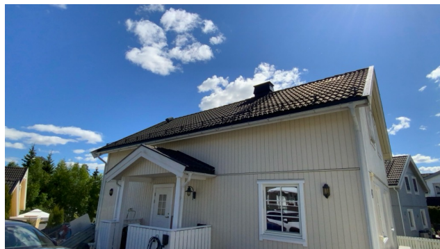
Besiktigelse av taktekke.
