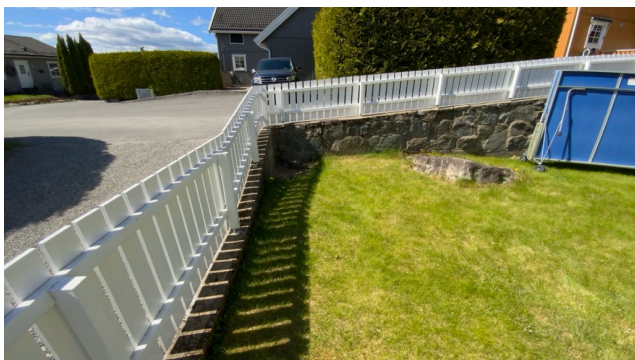
Besiktigelse av støttemur.
