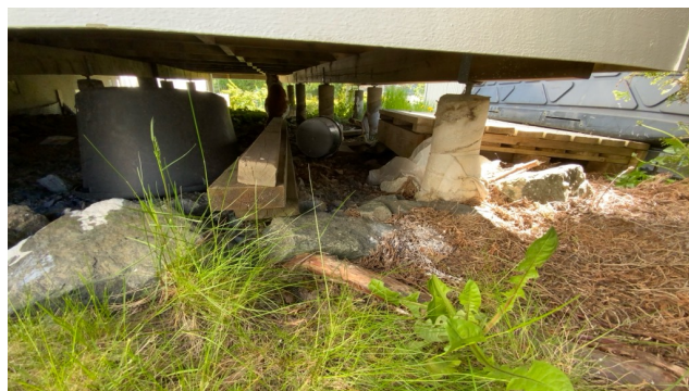
Kontroll av fundament.
