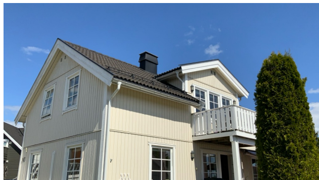
Besiktigelse av taktekke.
