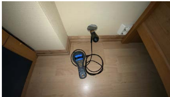
Utført hulltaking på rom under terreng.
