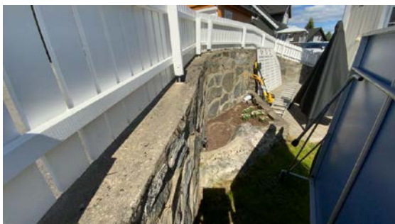
Besiktigelse av støttemur.
