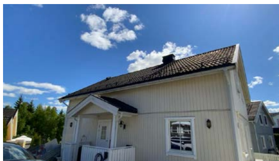
Besiktigelse av taktekke.
