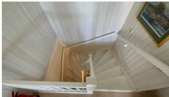
Besiktigelse av trapp.
