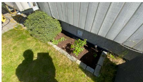
Kontroll av drenering/fuktsikring.
