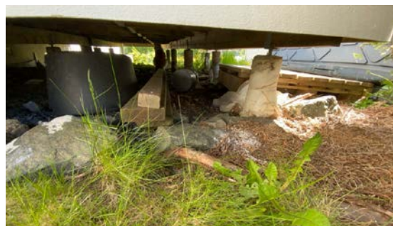
Kontroll av fundament.
