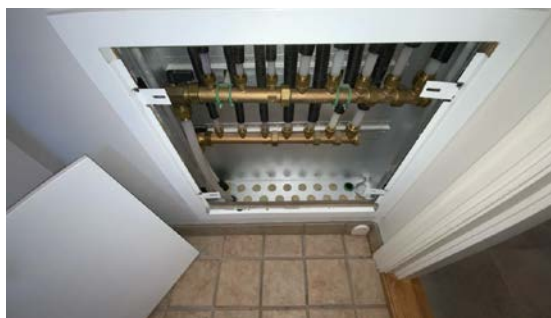
Besiktigelse av røropplegg.
