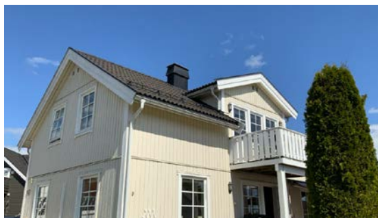
Besiktigelse av taktekke.
