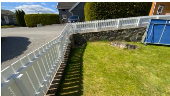
Besiktigelse av støttemur.
