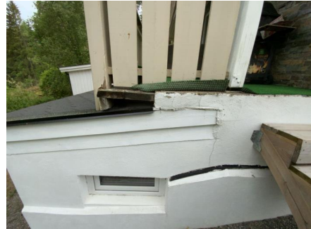
Ikke fagmessig utført tetting med beslag og drt er ikke synlig membran/teking i området.
