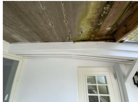
Ikke fagmessig utført tetting med beslag og drt er ikke synlig membran/teking i området.
