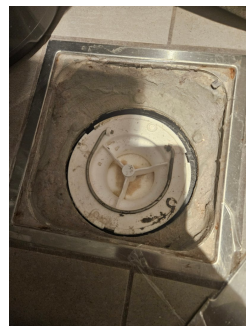
Kontroll av sluk utenfor dusjsonen.
