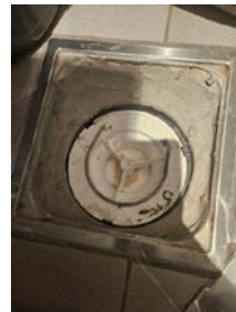
Kontroll av sluk utenfor dusjsonen.
