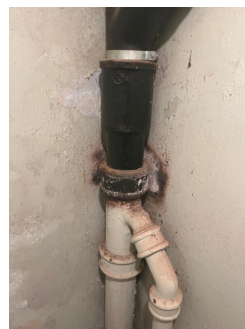
Utskiftet anlegg fra dette punktet.
