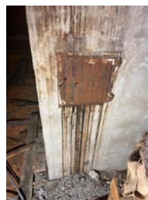
Feieluke på loft, kan ikke brukes lengre på grunn av nytt røykrør.
