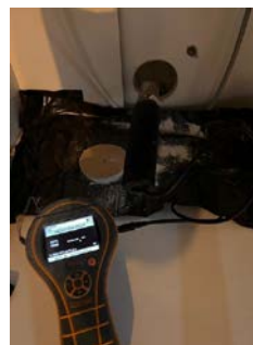
Fuktmåling i vegg mot våtsone
