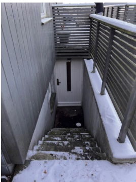
Kjellertrapp mangler håndløper på hver side av trapp.
