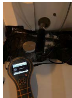
Fuktmåling i vegg mot våtsone
