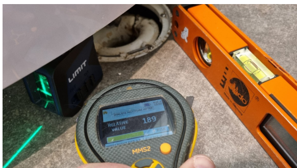
Fuktmåling og kontroll av fall mot sluk.
