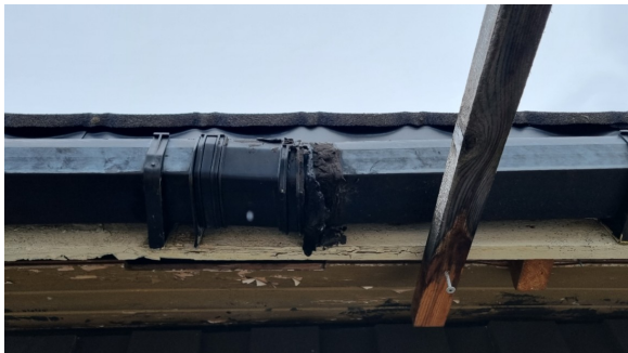
Utettheter i renne.
