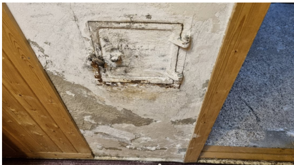
Kontroll av sotluken i kjeller.
