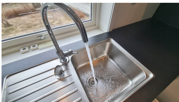
Kontroll av vanntrykk og avrenning.
