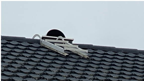
Visuell besiktelse av taket.
