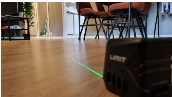
Kontroll av skjevheter med krysslaser, her fra leiligheten i 1. etasje.
