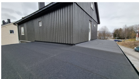
Takterrassen er oppført utenfor fasade nordvest og nordøst
