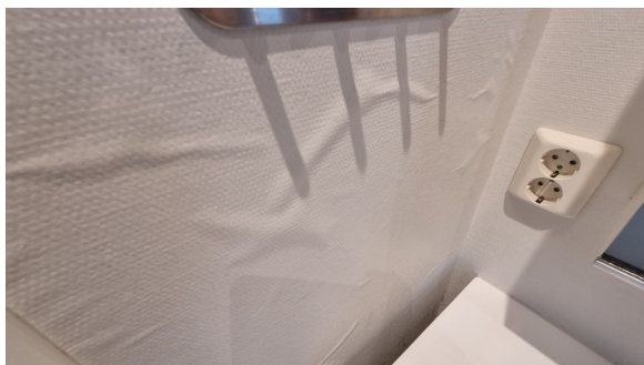
Tapet er ikke tilfredsstillende festet til underlaget.
