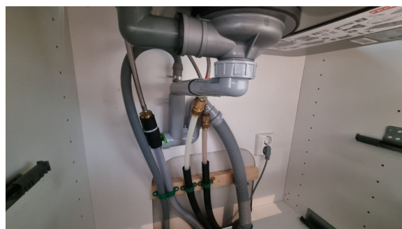
Kontroll av røropplegg under oppvaskkummen.
