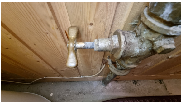
Kontroll av innvendig hovedstoppekran.
