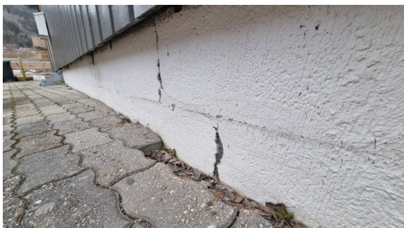
Kontroll av grunnmur under tilbygget del.
