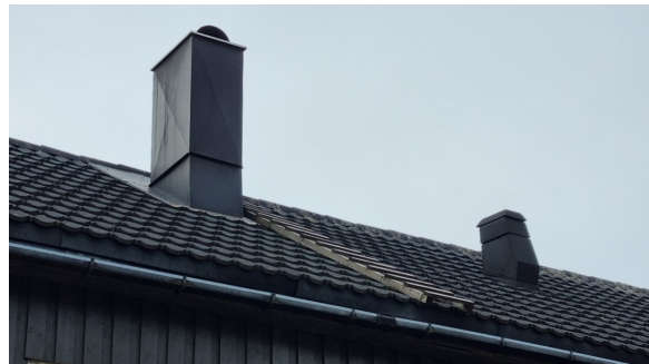
Visuell besiktelse av taket.
