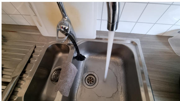
Kontroll av vanntrykk og avrenning.
