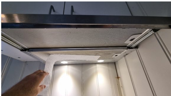
Funksjonstesting av det mekaniske avtrekket over komfyren.
