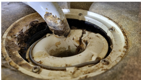
Kontroll av sluk.
