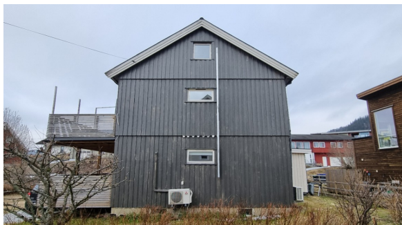
Brannstige montert på fasade sørøst.
