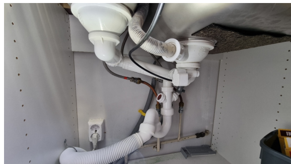
Kontroll av røropplegg under oppvaskkummen.
